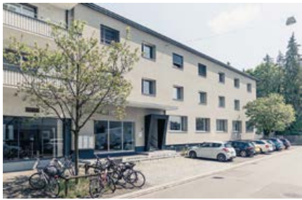
Das IBP Institut ist in den neuen Räumlichkeiten an der Mühlestrasse 10 in Winterthur schon ganz heimisch.
